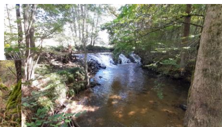
Relevé diagnostic - seuil infranchissable
