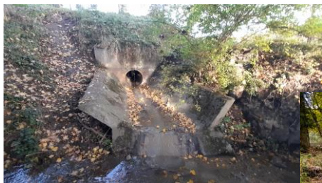
Relevé diagnostic - rejet au cours d'eau
